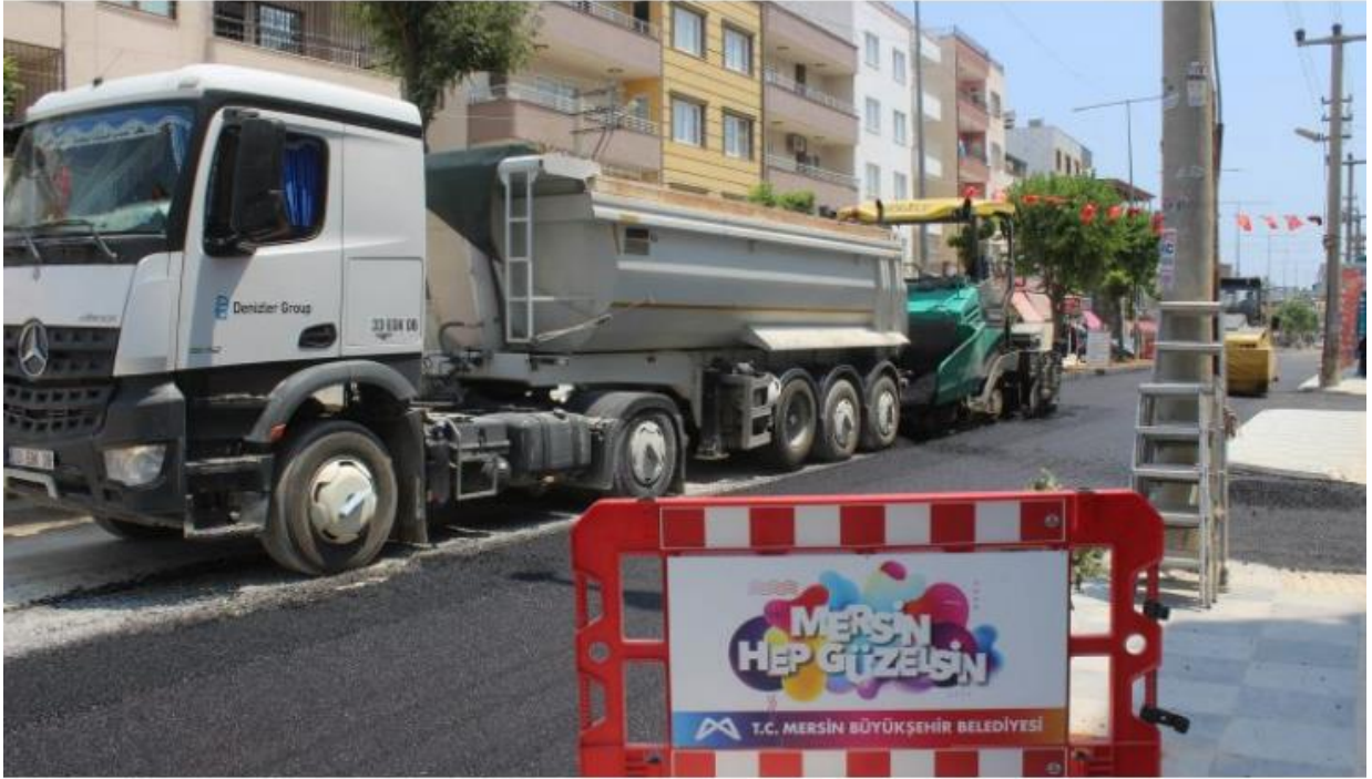
Büyükşehir Yol Yapım Bakım ve Onarım çalışmaları
